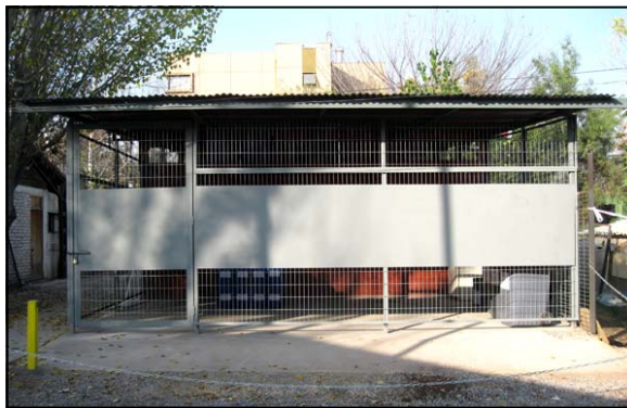
La nueva bodega de residuos sólidos y líquidos reúne las características exigidas por la normativa vigente para este tipo de recintos
