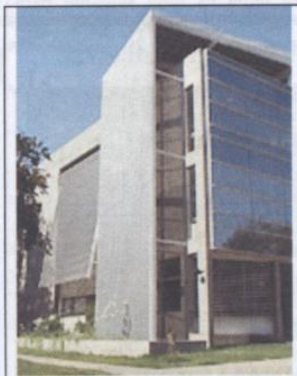
Edificio del Departamento de Biología y del Instituto Milenio.
