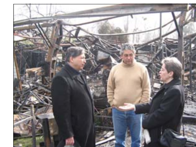
Incendio destruye parte de laboratorios de Biología y Química
