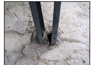
Los pilares de las construcciones más antiguas también sufrieron los rigores del movimiento telúrico
