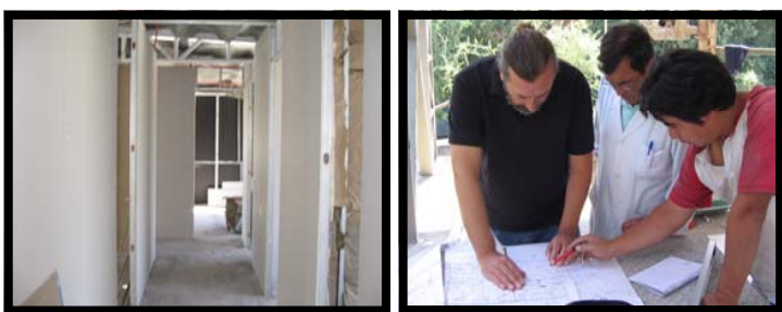
Distintas fases en la implementación del nuevo edificio que Albergará a los Dres. Humberto Maturana, Juan Carlos Letelier, Jorge Mpodozis y Alex Vargas.
